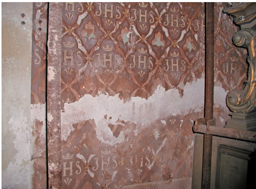
Obr. 3. Šablonová výmalba dolní části presbyteria.
