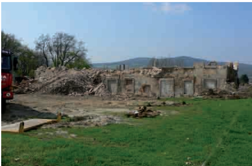
Obr. 12. Hrádek nad Nisou (okres Liberec), dům č. p. 65, 66, tzv. Azyl. Zbytky objektu po demolici střechy, krovu a prvního patra, stav 26. 4. 2006 (foto M. Kolka).
