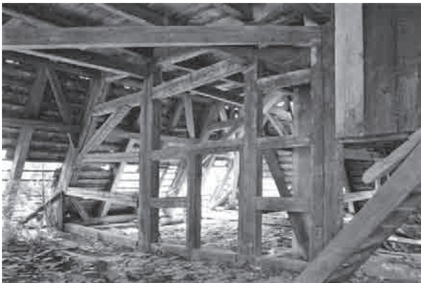
Obr. 8. Hrádek nad Nisou (okres Liberec), dům č. p. 65, 66, tzv. Azyl. Pohled do jižní části půdního prostoru od severovýchodu, uprostřed jsou pravděpodobně nedokončené konstrukce dřevohlinitých příček, stav v roce 2000 (fotografický archiv NPÚ, územní odborné pracoviště v Liberci, foto R. Kursá).
