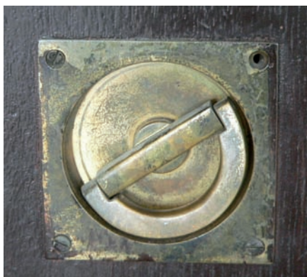
Obr. 11. Detail kování zasunovacích dveří mezi dvoranou a budoi-rem, foto 2005.
