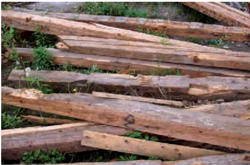
Obr. 15. Hrádek nad Nisou (okres Liberec), dům č. p. 65, 66, tzv. Azyl. Skládka prvků krovu po demolici objektu, stav v květnu 2006. Uprostřed snímku je sloupek ležaté stolice s dlaby po symetrických pásčích podélného zavětrování, za ním pravděpodobně krokev (foto M. Panáček).
