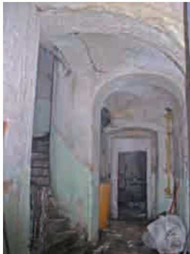
Obr. 12. Dům č. p. 1326, chodba a schodiště v přízemí. Stav březen 2006 (foto I. Habán).
