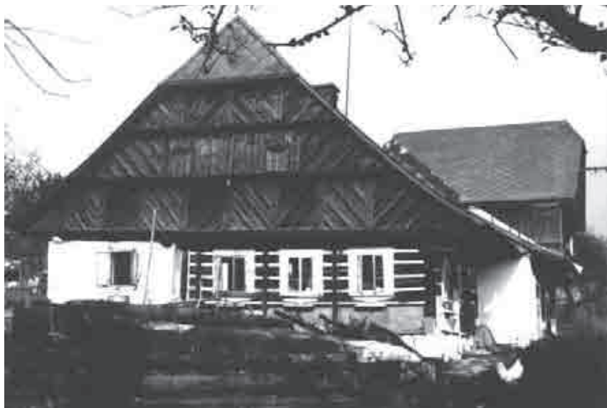
Obr. 1. Pohled na hlavní průčelí domu, 70. léta 20. století.
