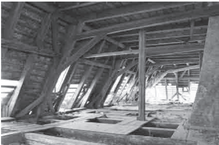
Obr. 7. Hrádek nad Nisou (okres Liberec), dům č. p. 65, 66, tzv. Azyl. Celkový pohled do východní části půdního prostoru od severu, dobře je vidět konstrukce ležaté stolice, stav v roce 2000 (fotografický archiv NPÚ, územní odborné pracoviště v Liberci, foto R. Kursá).
