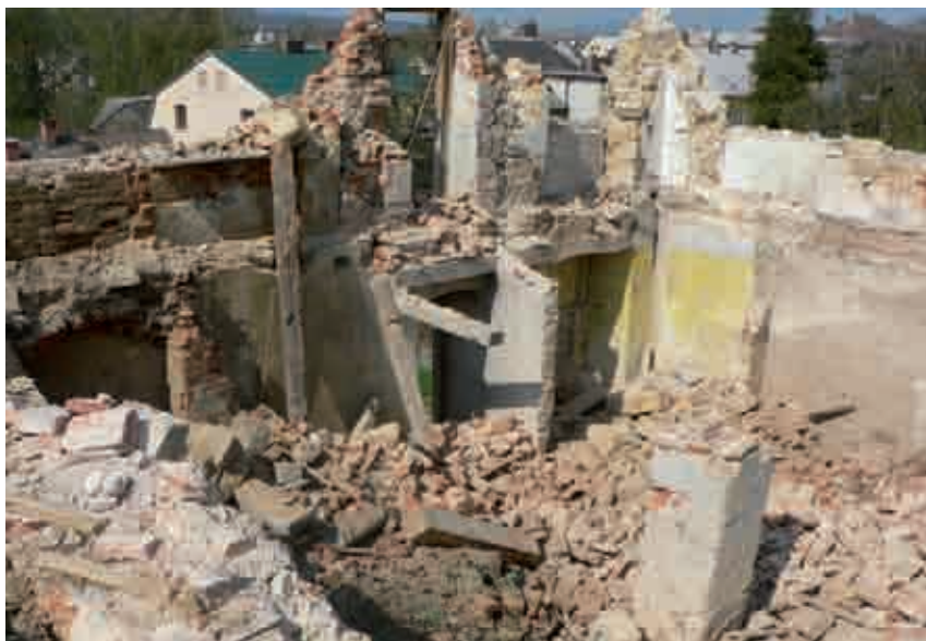
Obr. 13. Hrádek nad Nisou (okres Liberec), dům č. p. 65, 66, tzv. Azyl. Zbytky jihozápadního nároží objektu po demolici střeby, krovu a prvního patra, stav 26. 4. 2006 (foto M. Kolka).
