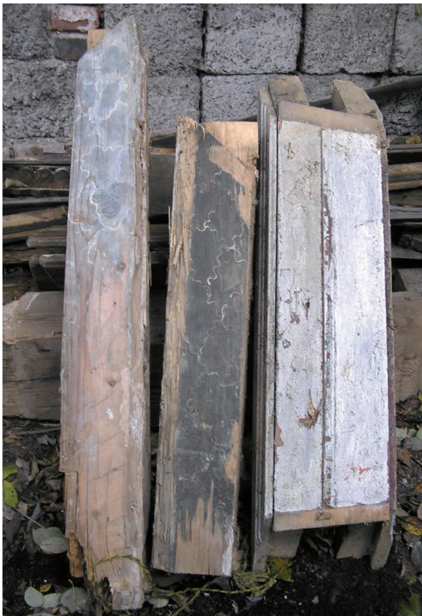
Obr. 3. Část trámkového okenního ostění bez obložky a s dodatečnou obložkou (kus zcela vpravo).
