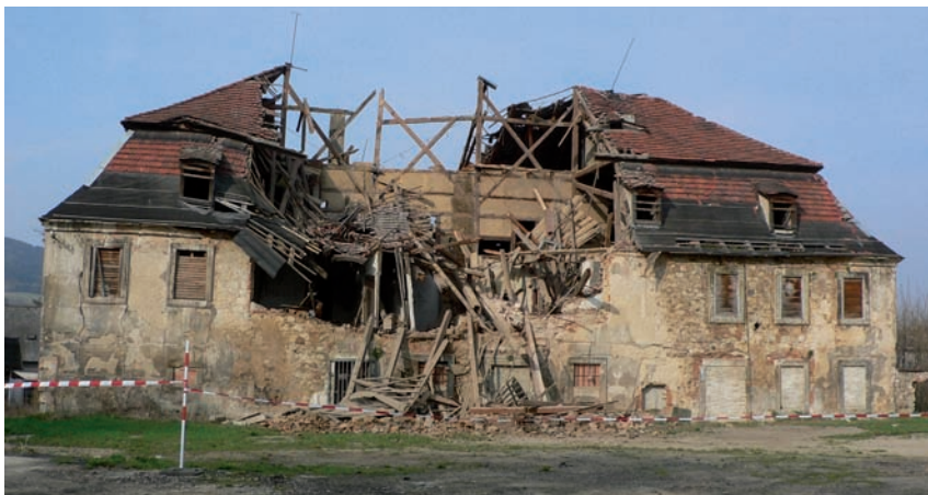
Obr. 9. Hrádek nad Nisou (okres Liberec), dům č. p. 65, 66, tzv. Azyl. Celkový pohled na objekt od východu, stav v dubnu 2006 po zřícení střední části střešní konstrukce (foto M. Kolka).
