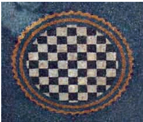
Obr. 18. Kazeta stropu dvorany, foto 2005.
