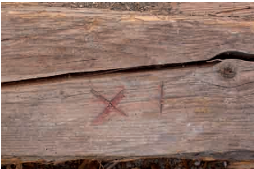
Obr. 16. Hrádek nad Nisou (okres Liberec), dům č. p. 65, 66, tzv. Azyl. Skládka prvků krovu po demolici objektu, stav v květnu 2006. Detail tesařského značení v podobě římské číslice XI, vyseknutého sekerou a zvýrazněného rudkou (foto M. Panáček).
