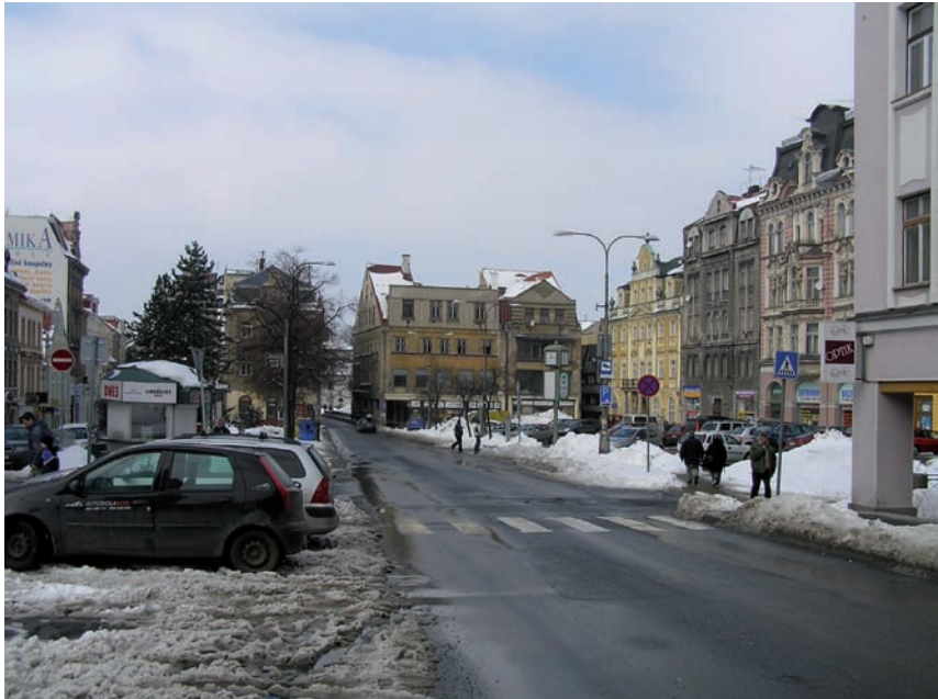
Obr. 13. Sokolovské náměstí, celkový pohled před demolicí domu č.p. 1326.
