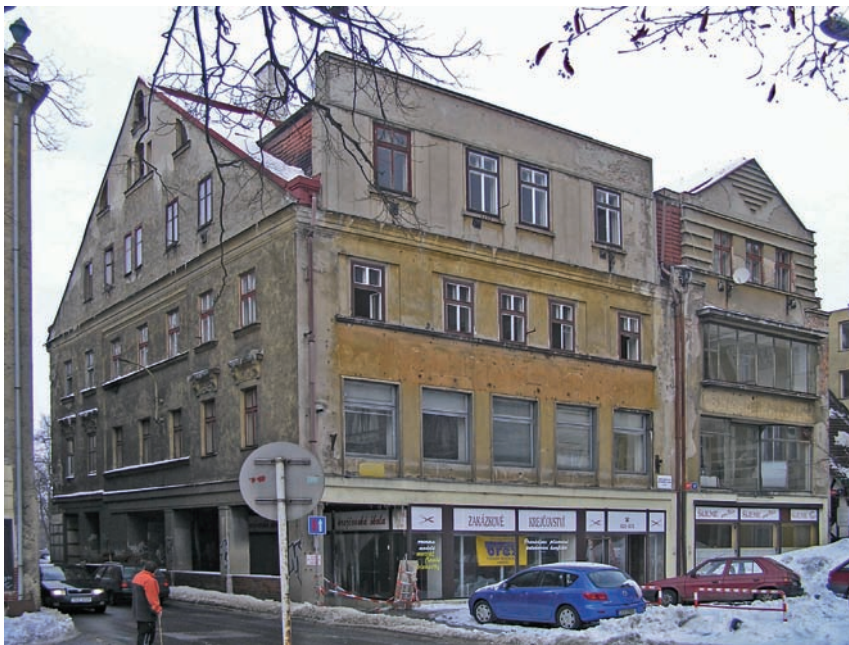
Obr. 10. Dům č. p. 1326 (vlevo) společně s domem č. p. 277 na Sokolovském náměstí těsně před demolicí, 14. 3. 2006 (foto I. Habán).
