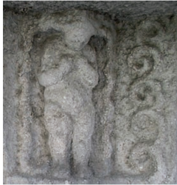
Obr. 12. Detail konzoly balkónu severovýchodního průčelí, foto 2005.
