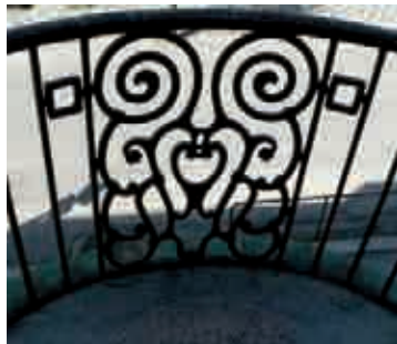
Obr. 26. Detail zábradlí balkónu uliční fasády, foto 2005.
