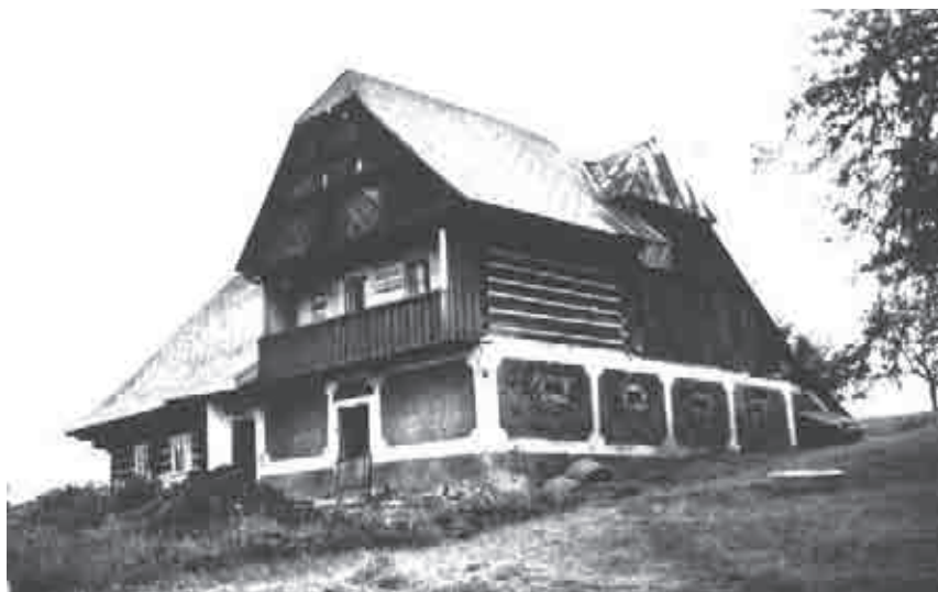
Obr. 2. Pohled na boční průčelí domu, 70. léta 20. století.
