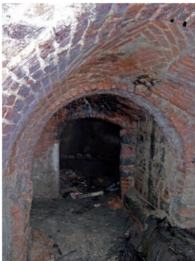
Obr. 11. Dům č. p. 1326, klenuté sklepní prostory ve druhém podzemním podlaží. Stav březen 2006 (foto I. Habán).
